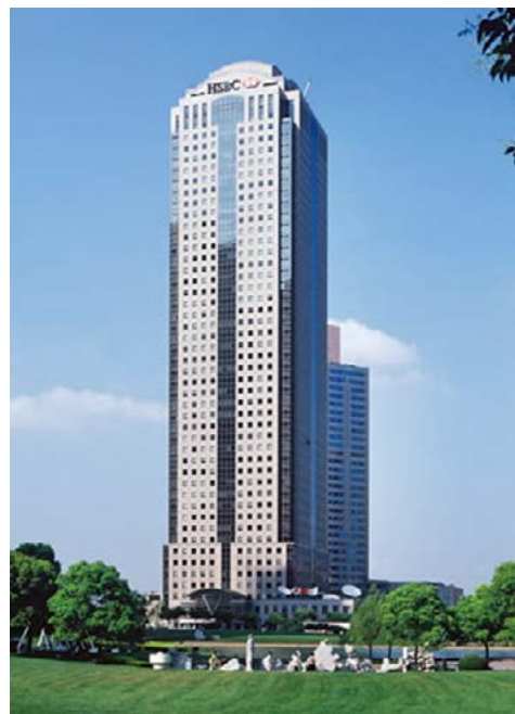
上海森茂国际大厦空调工程
