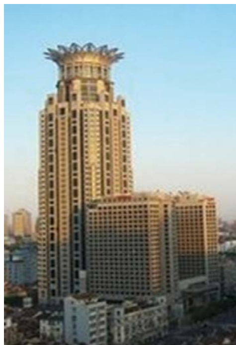
上海威斯汀酒店综合机电工程
